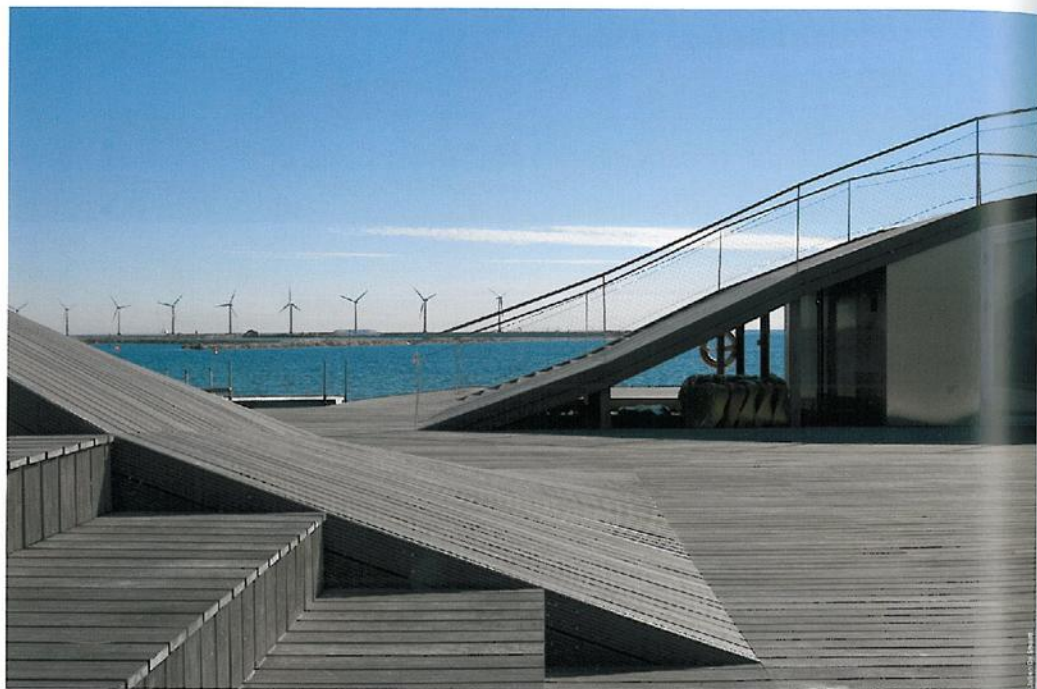
I due edifici sono rivestiti da un'unica copertura di legno continua The two building are covered by one single continuous timber roof
